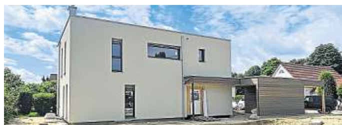
Das Haus und das beigefügte Schuppenmodul erscheinen am Ende wie aus einem Guss. Dank eingespielter Arbeitsabläufe wird ein Haus von JURA-HOLZBAU an einem einzigen Tag regendicht aufgebaut.
