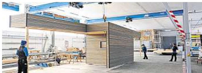
Wenn ein Haus auch noch mit einem Schuppen und einem Carport ausgestattet werden soll, wird das schon mal als ganzes Modul in der Werkhalle vorbereitet. Fotos: JURA-HOLZBAU
